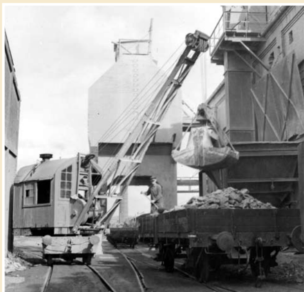
Kopparverket; Ångkran ombyggd till dieseldrift lastar lera från järnvägsvagn till fabriken intagsficka vid rostugnarna, ca 1951.
