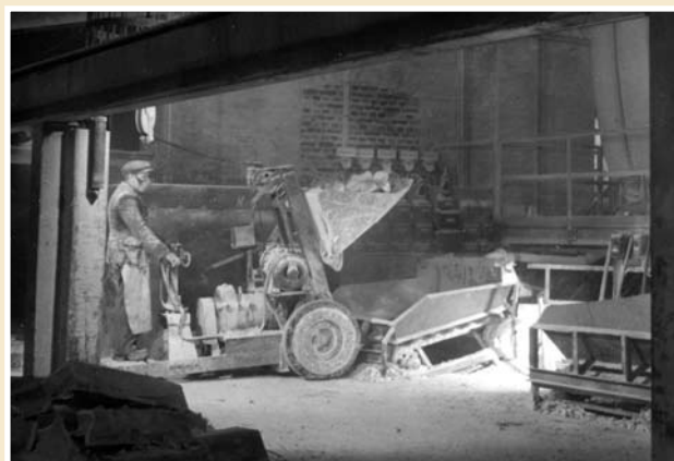
Kopparverket, ca 1945, framkörning av alsulfat till hammarkvarn med egen tillverkad lastmaskin.
